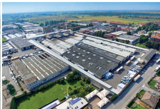
Trezzano sul Naviglio Plant, Italy
